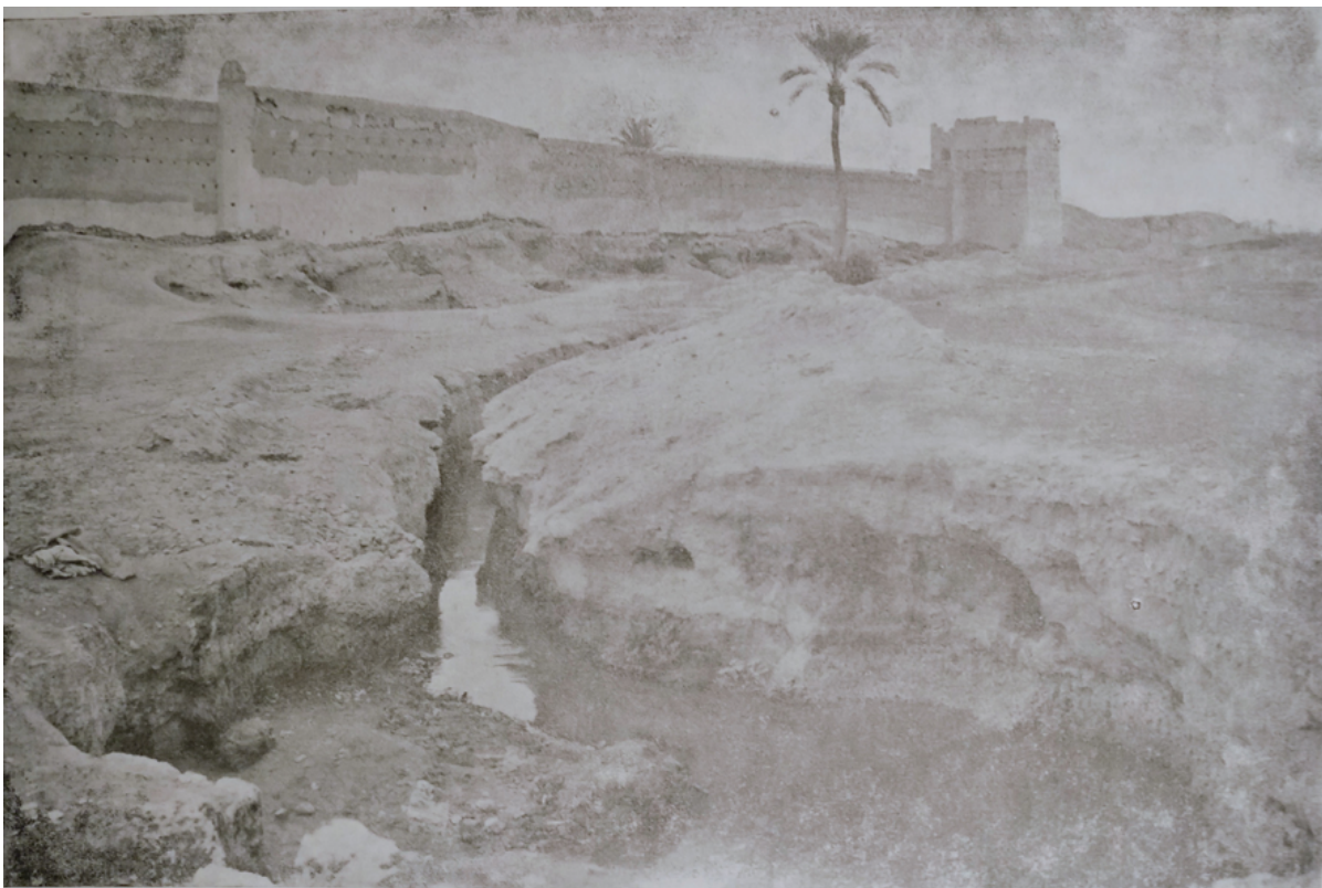
Figure 16. “Khattara: arrivée de l’eau à la surface du sol: à droite du bastion collines de vieilles ordures” (Deverdun Pl. VI).
