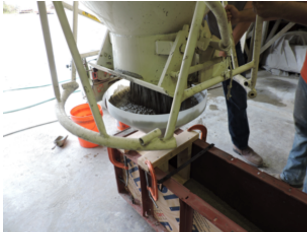
Figure 3.2 Flow Test SCC Pour
