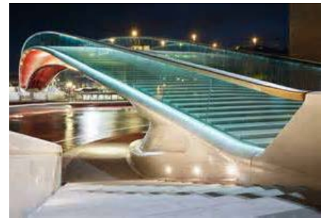
Ponte della Costituzione Bridge
