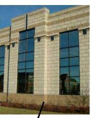
CONCRETE MASONRY UNIT WALL SYSTEM
