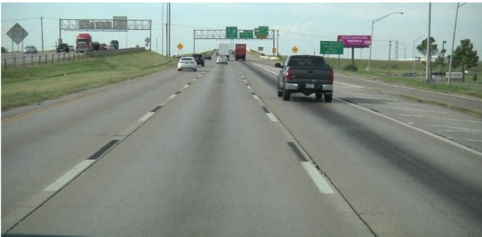
(c) Rigid Pavement (OK-I44)
