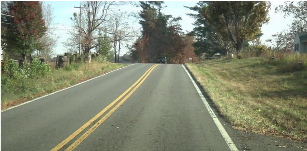
(b) Flexible Pavement (TN-298)
