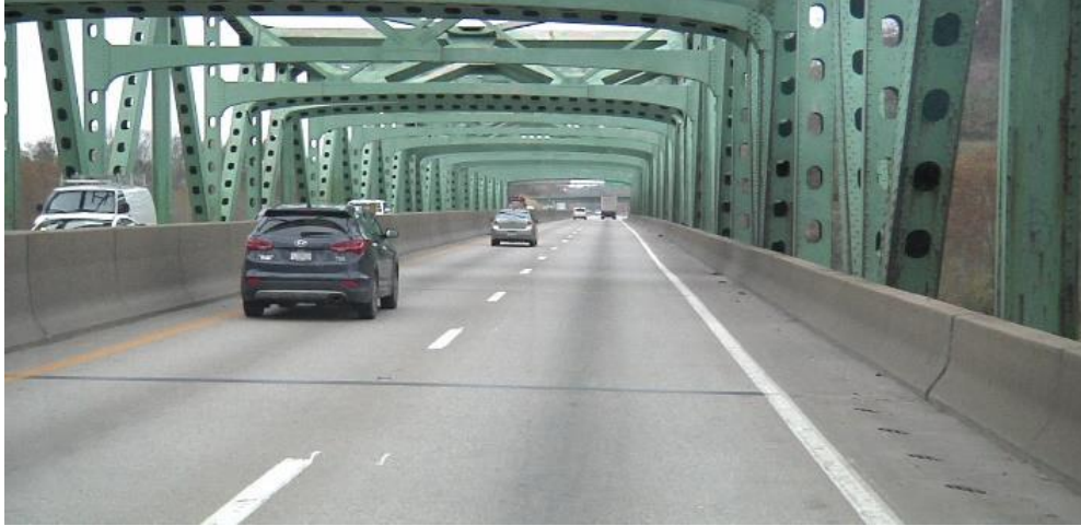
(d) Bridge Deck (WV-I64)
