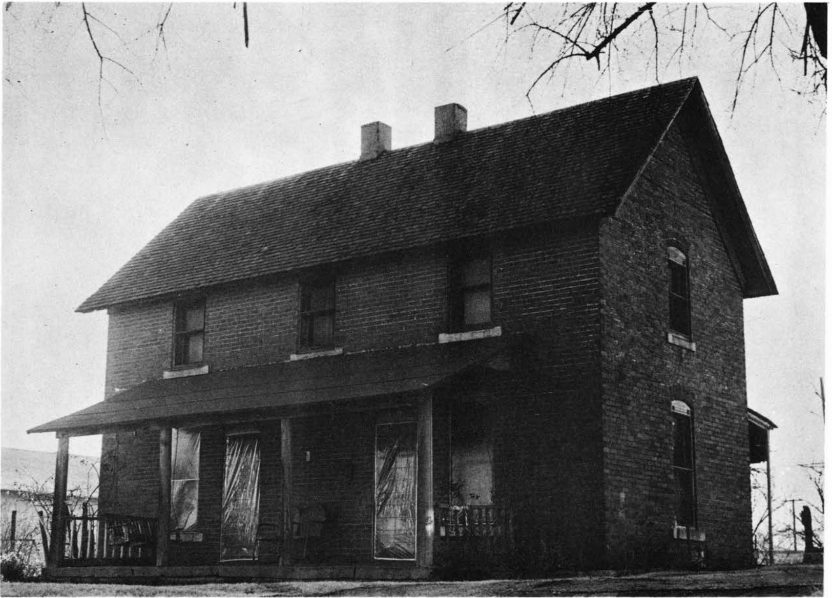
Figure 29 THE FRANKLIN N. BACON HOUSE
